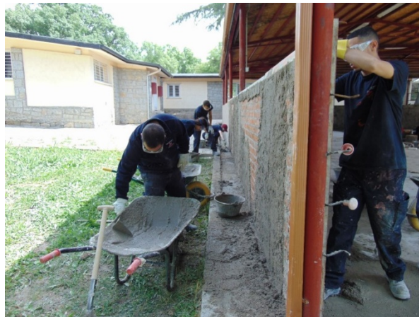
Enfoscado con mortero
