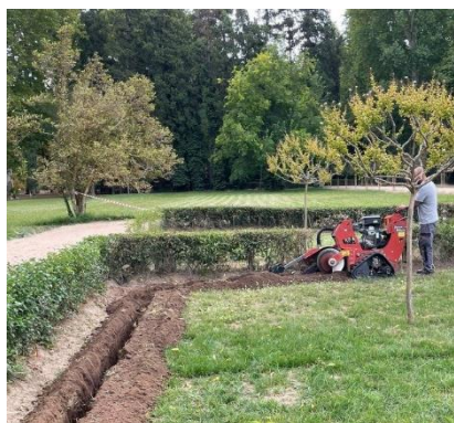
Apertura de la zanja para instalación de riego automatizado y mejora de la eficiencia
