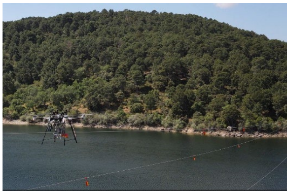
Colocación de balizas en la Línea de Alta tensión de Guadarrama- Valle de Cuelgamuros en el vano volado sobre el embalse de La Jarosa.
