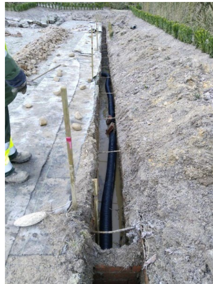
Colocación de drenajes en el entorno de los parterres de Eolo, mediante zanja y tubería perforada para evitar acumulaciones de agua
