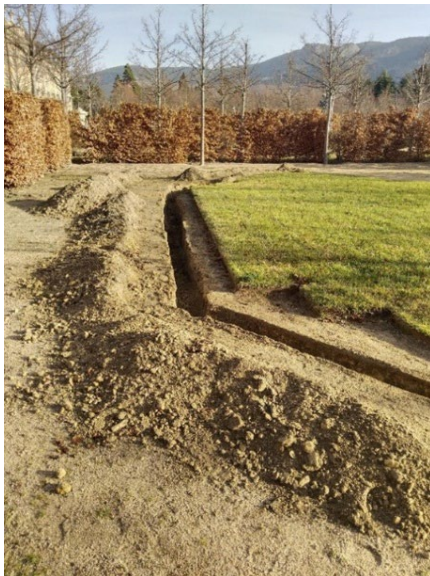
Colocación de drenajes en el entorno de los parterres de Eolo, mediante zanja y tubería perforada para evitar acumulaciones de agua
