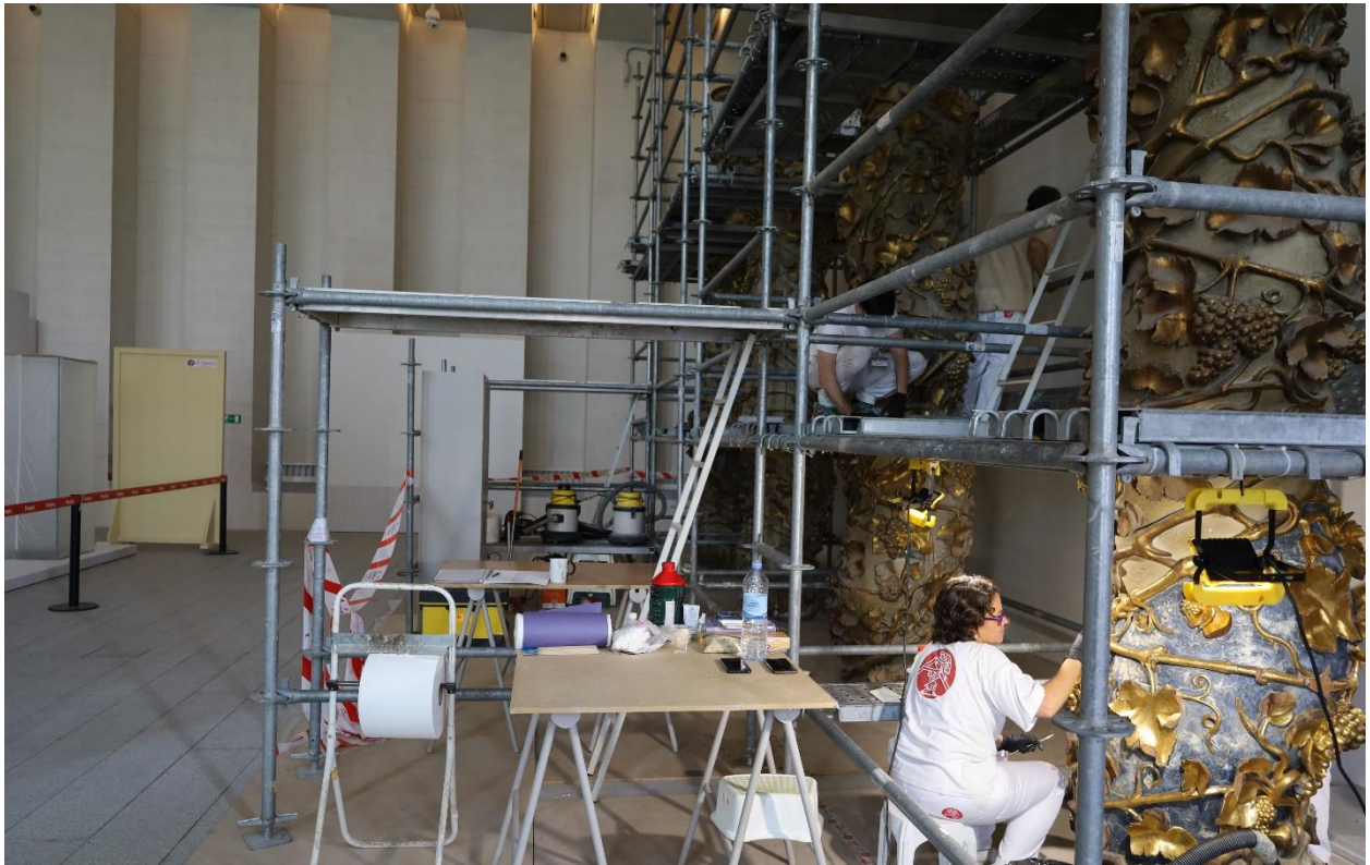
Arriba, las columnas entre andamios para posibilitar los trabajos de restauración. Abajo, una restauradora
