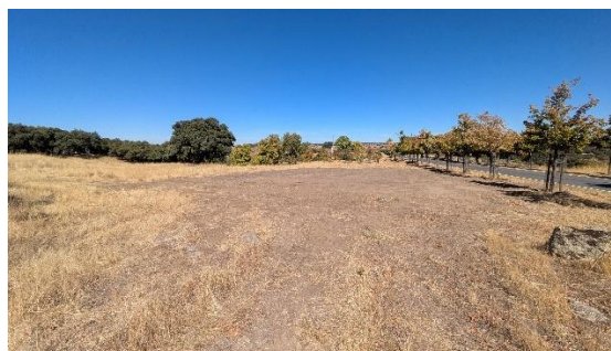
Aporte de tierra vegetal para restauración de terreno tras la 1ª fase de obra de implantación de la nueva red de saneamiento de Palacio
