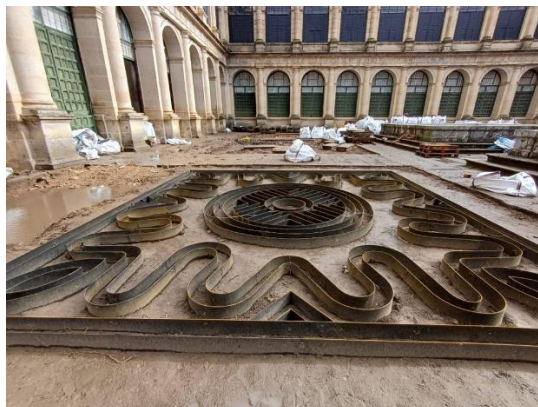
Comienzo de restauración del claustro de los Evangelistas
