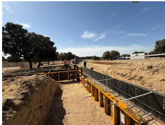
Proyecto y fase 1 de la construcción de captadero en El Pardo (Tejada)
