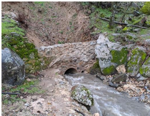
Primera fase de obra de drenaje transversal de emergencia en el cruce del arroyo Batán
