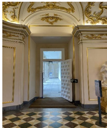
Adecuación de puerta de comunicación de la planta baja del Palacio de La Granja al Patio de La Fuente
