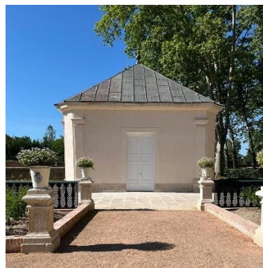
Carpinterías en el Pabellón Real en el Jardín del Príncipe
