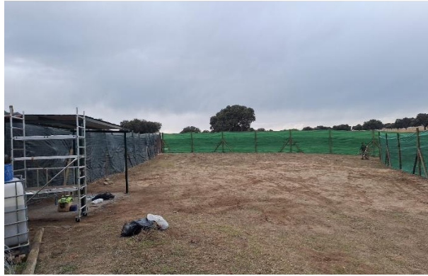
Construcción de nuevos corrales de espera y cuarentena en el captadero de La Pedragosa
